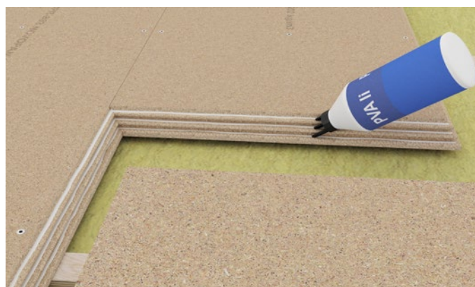
Figur 5 Applicera rikligt med lim på fjäderns alla tre övre sidor. Torka av överflödigt lim. Limma skivor mot alla regler.
